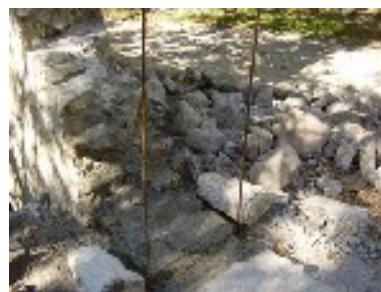
Démontage partiel permettant de recréer un harpage.
