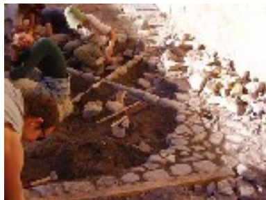
Remplissage entre les conducteurs.
