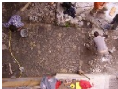
Insertion des cales de blocages
