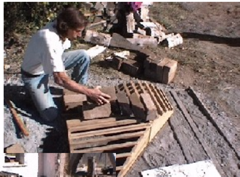
Les briques des arêtes sont taillées en diagonale
