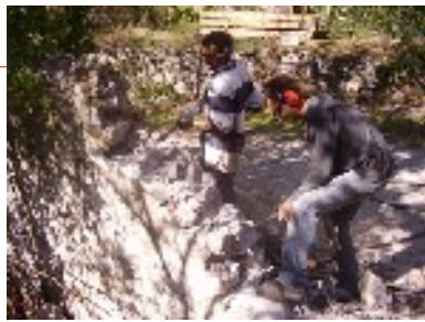
Réparation d'une tête de mur.
