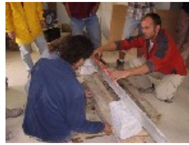
Vérification de l'assise de l'arc.
