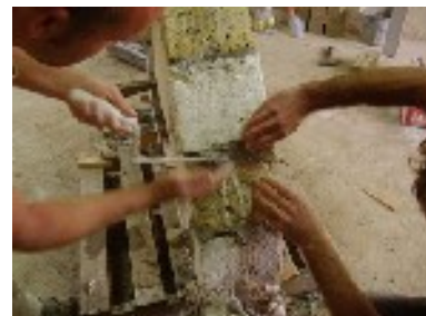
Fermeture des joints avec le même mortier.
