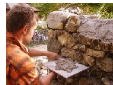
Remplissage des joints au fer à joint.
