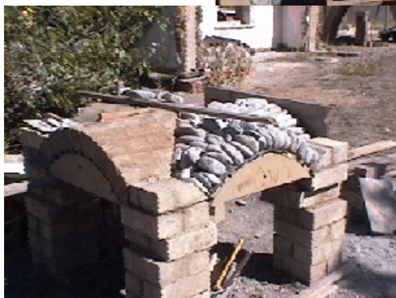
Les briques des arêtes sont taillées en diagonale
