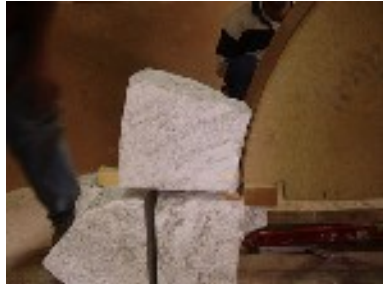
Les pierres sont posées sur cal.
