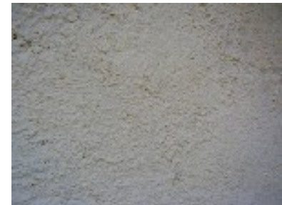
Enduit au balai
