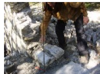
Remplissage des joints verticaux.
