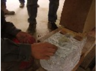
Le cintre est posé sur des coins à marier, boîte à sable ou des vérins
