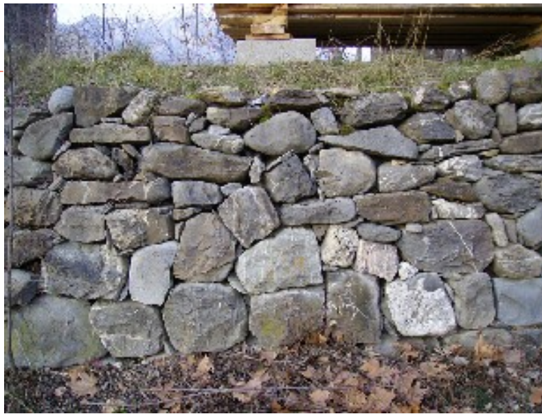
Mur de pierre sèche
