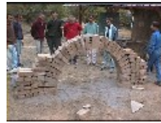
2- après décoffrage on vérifie qu'il est stable.
