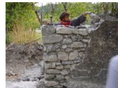
Réalisation de l'arase et préparation du couronnement.
