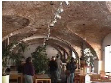
Voûte en panier.
