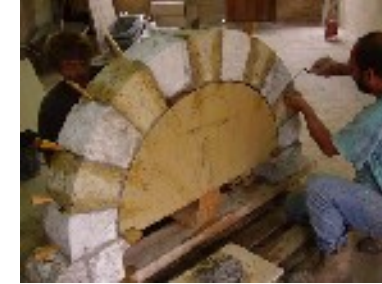
Réalisation des joints au mortier.(1V de Nhl, 2,5 V de sable)
