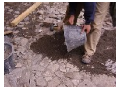
Vieillisement au sable.
