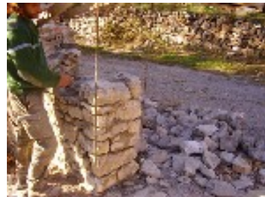
Réparation d'une tête de mur.
