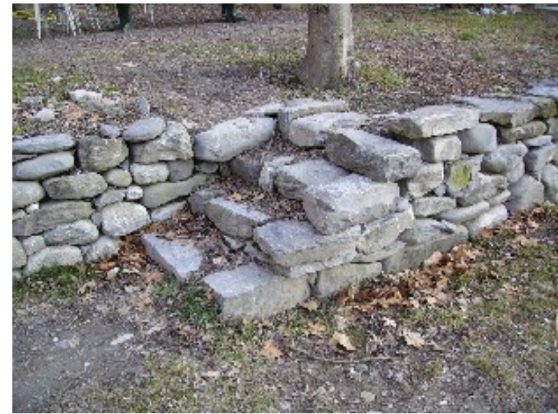
Mur et escalier en pierre sèche.
