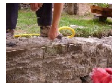
Nettoyage au jet des coulures de mortier.
