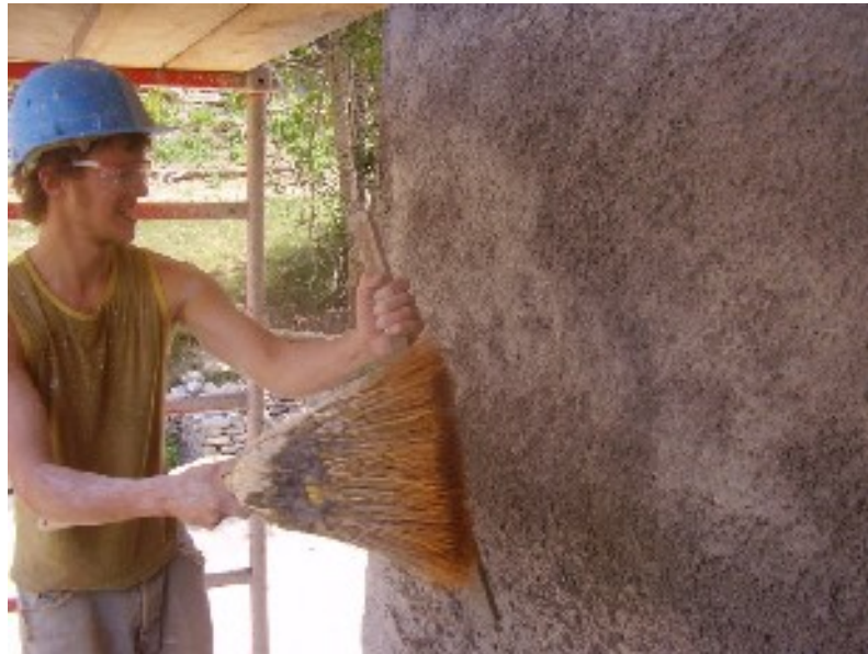
Reconstitution d'un enduit au balai
