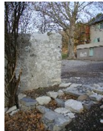
Tête de mur maçonnerie et escalier en pierre sèche.
