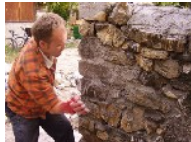
Remplissage des joints à la main.
