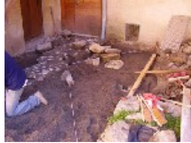
Mise en place des coffrages et des cordeaux de conducteurs
