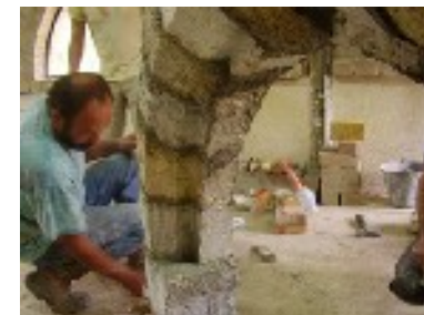
Nettoyage du dessous de l'arc.
