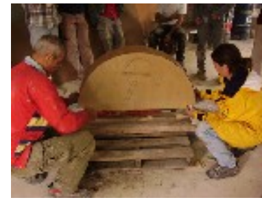
Mise en place du cintre
