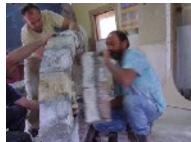
Décintrage immédiat pour mettre l'arc en pression.
