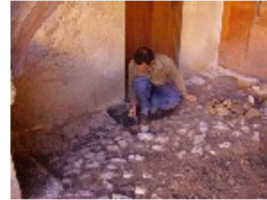
Démontage et remontage des parties affaissées.
