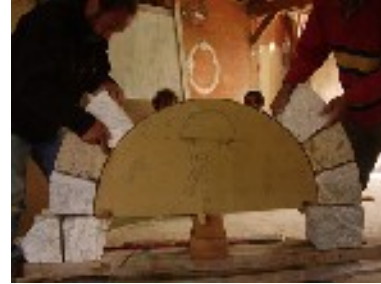
La mise en place est symétrique pour éviter la poussée du cintre.
