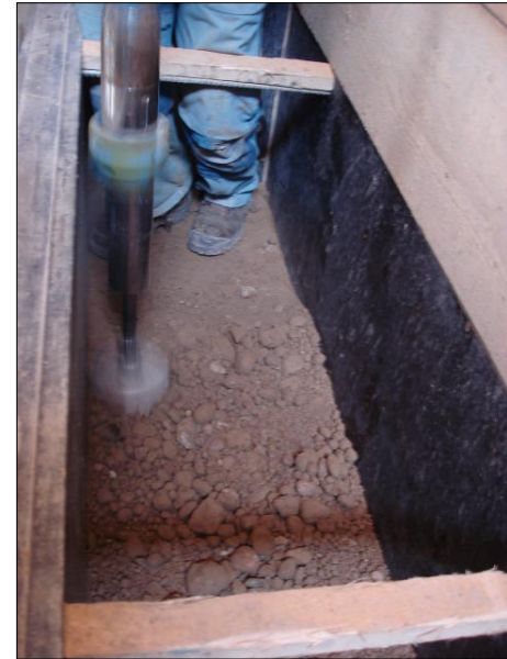
Les écarteurs en bois et les barres de clés de banquettes obligent à les enjamber systématiquement avec le fouloir et gênent fortement lorsque le niveau de terre en est très près.
