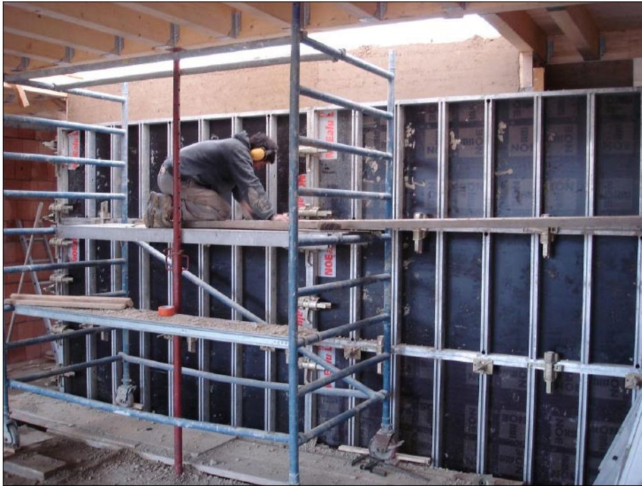
Les différentes phases de décoffrage du premier mur au rez-de-chaussée.
