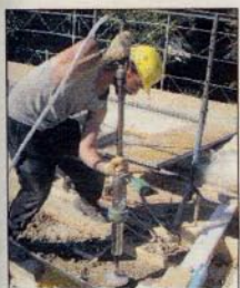
Olivier Krumm tasse le pisé avec une dame pneumatique.
