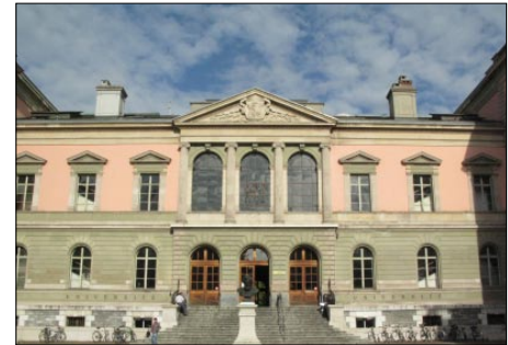
Bâtiment principal de l'université des Bastions de Genève dont tout le rez-de-chaussée et les encadrements sont en molasse.
