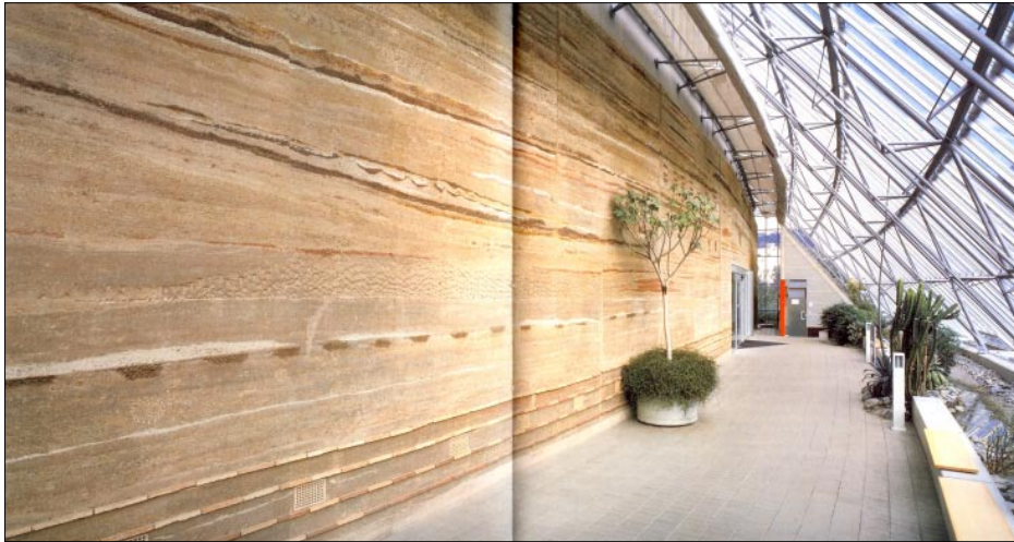
Maison de Martin Rauch, à Schlins. Des lits de briques cuites horizontales sont régulièrement disposés pour limiter l'érosion du mur dans le temps. Source : Le Temps, Genève, 9 juillet 2008.
