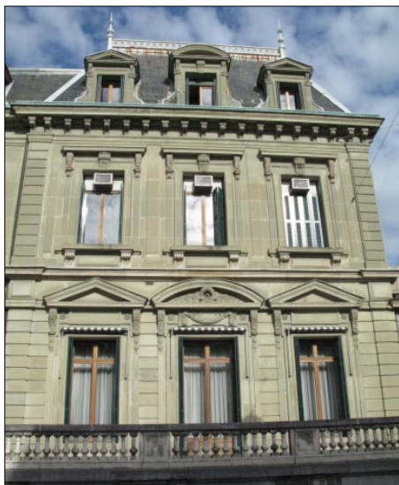
Maison bourgeoise du centre-ville de Genève. Le bâtiment est bâti en molasse avec son soubassement en calcaire.
