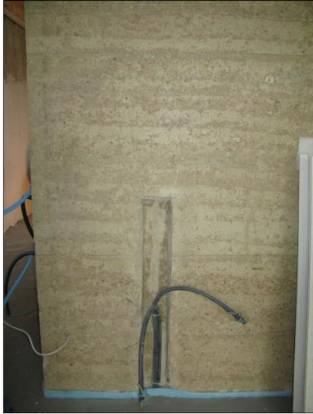
Saignée pour l'électricité qui sera rebouchée en mortier de terre.
