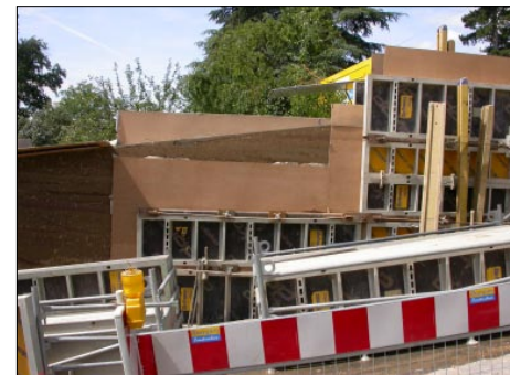
Des panneaux fins de contreplaqué sont disposés à l'intérieur des banches pour que les joints de coffrage n'apparaissent pas au final. Photo : Ch. Von During
