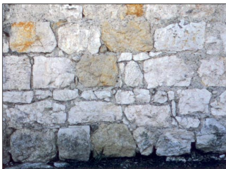
Trois types de maçonnerie en moellons (de haut en bas) : provenance géologique diverses non-équarris, molasse de carrière partiellement équarris, calcaire partiellement équarris soigneusement appareillés.
