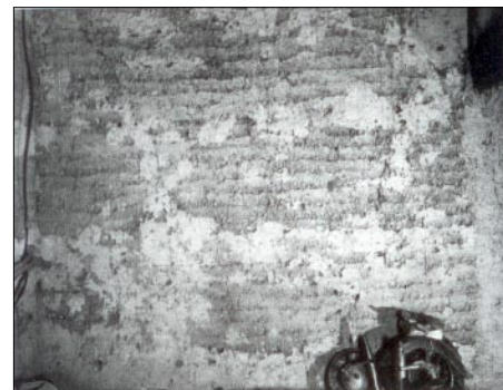
Mur intérieur de la grange d'une maison paysanne avec traces de badigeon à la chaux. Photo extraite de : Les maisons rurales du canton de Genève, Op. Cit.
