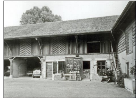
Dépendance agricole postérieure à 1850. L'étage est fermé par un bardage à claire-voie. Ce cas de figure se retrouve souvent : utilisation de maçonnerie au rez et d'une ossature bois à l'étage.
