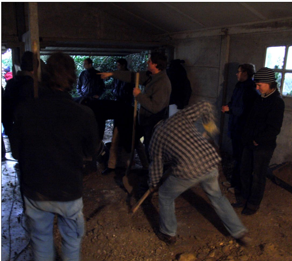
Journée de sensibilisation à la construction en terre locale. L'ajout d'eau à la terre était fait au sol et les échantillons dans des coffrages préalablement réalisés.
