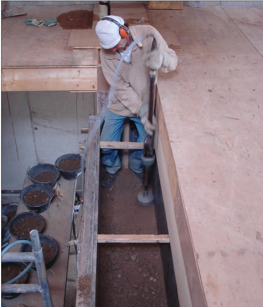
Pisage de la terre au fouloir pneumatique. Il faut s'imposer un systématisme dans le mouvement pour avoir un damage homogène.
