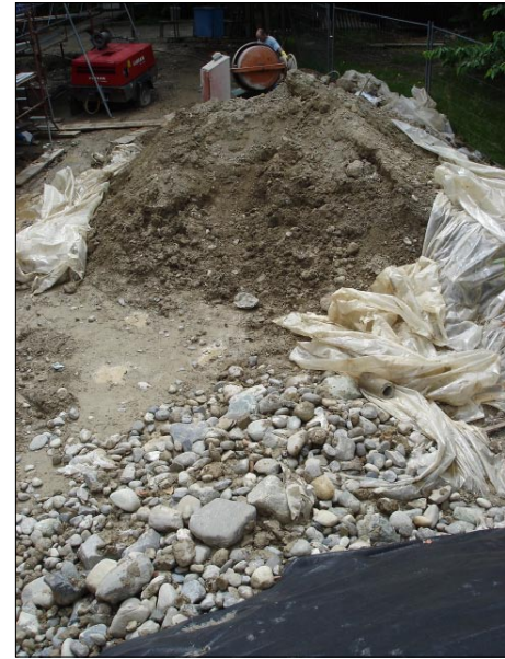
Au premier plan, les nombreuses pierres de grosse taille qu'il a fallu extraire de la terre à pisé.
