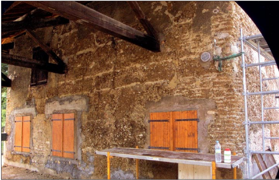
Réparation d'un angle de mur en «pisé coulé», une technique mise au point pour faciliter ce genre de reprise en terre.
