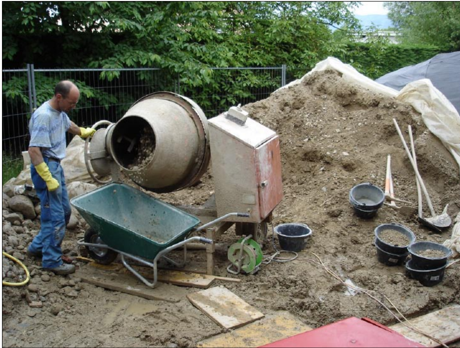
Déversement de la terre dans la brouette qui permet de la transporter jusqu'au bas du mur. Deux brouettes sont nécessaire à vider la bétonnière de 180 litres.
