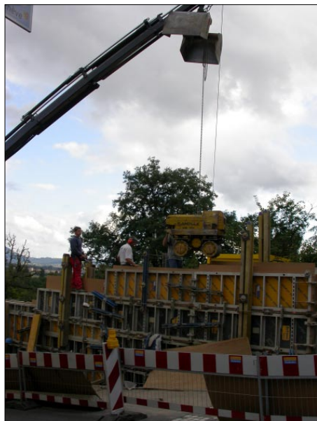
La fameuse machine que Martin Rauch a mis au point pour pisser la terre de manière mécanique. Photo : Ch. Von During
