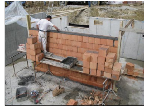
Mise en oeuvre du mur en brique monomur, base du futur mur en pisé.
