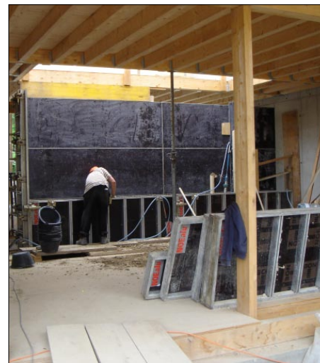
Coffrage prêt à être utilisé au rez-de-chausée de la villa.
