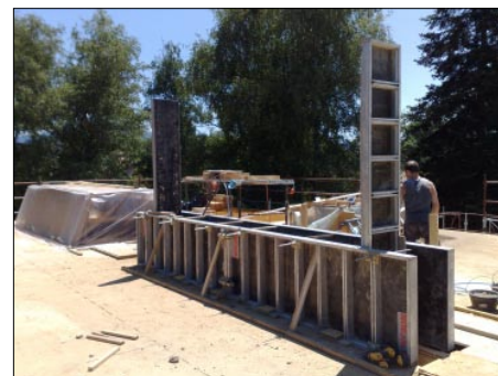
Coffrage en toiture pour les 85 cm de dépassement du mur dans le lanterneau.
