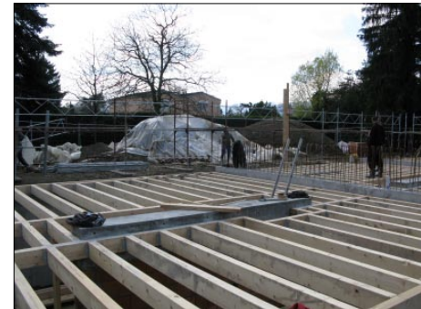
Solivage posé contre le mur en terre cuite avec les réservations pour les clés de départ du coffrage.
