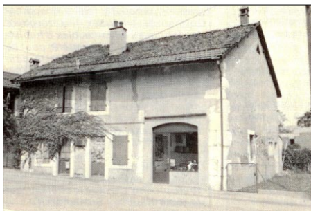
Maison en pisé située au centre du village de Meyrin, répertoriée par le groupe de recherche sur le pisé de l'EPFL. Photo extraite de la postface de : Bâtir en pisé, Op.Cit
