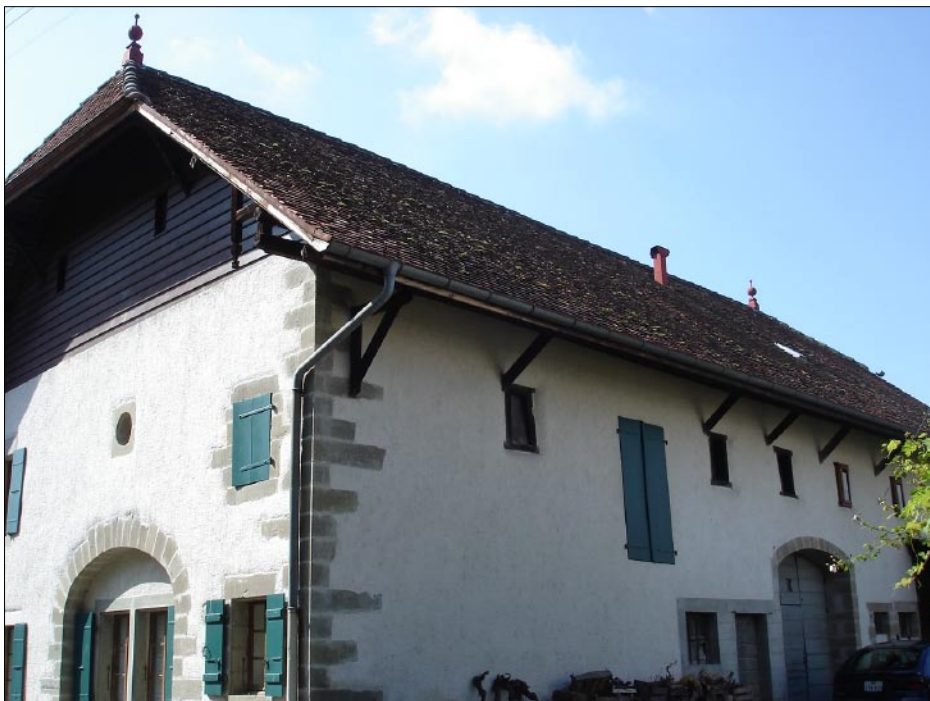
Ferme de Confignon partiellement construite en pisé. Le mur pignon est en «boulet», terme désignant la maçonnerie en gros galets, et les façades latérales sont en terre.
