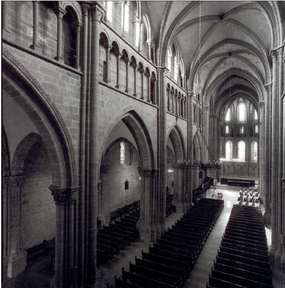
Nef centrale de la cathédrale Saint-Pierre, édifice du XII ème siècle, dont la réforme protestante du XVI ème siècle a largement transformé l'intérieur au regard de sa philosophie d'austérité (destruction des ornements et peintures), et a ainsi mis à nu l'ensemble des appareillages en pierre qui la constitue. Photo : CHARDONNENS G., Genève, vieille-ville, vieilles rues, Editions Slatkine, Genève, 1999.
