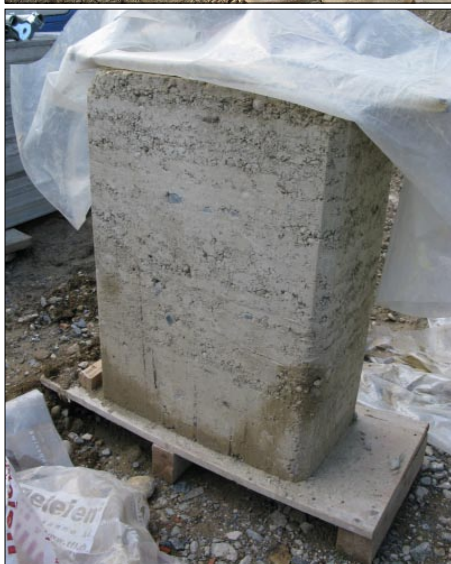
Terre extraite du terrassement (en haut) avec 70 m 3 de réserve pour la réalisation des murs et échantillon de mur (en bas) stocké sur le chantier. L'échantillon retenu par les clients fut celui stabilisé à la chaux.
