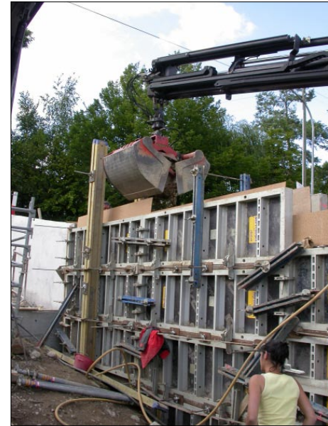
Un camion-grue est utilisé pour disposer la terre dans les coffrages. Photo : Ch. Von During
