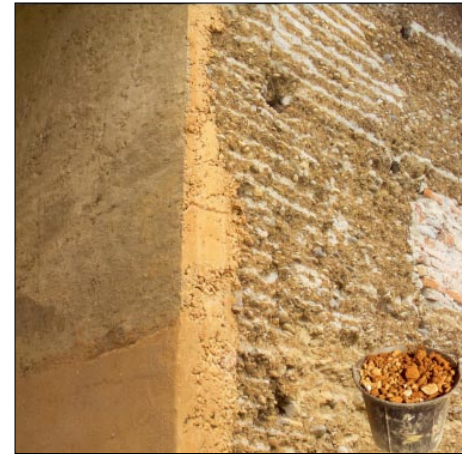
Réparation d'un angle de mur en «pisé coulé», une technique mise au point pour faciliter ce genre de reprise en terre.
